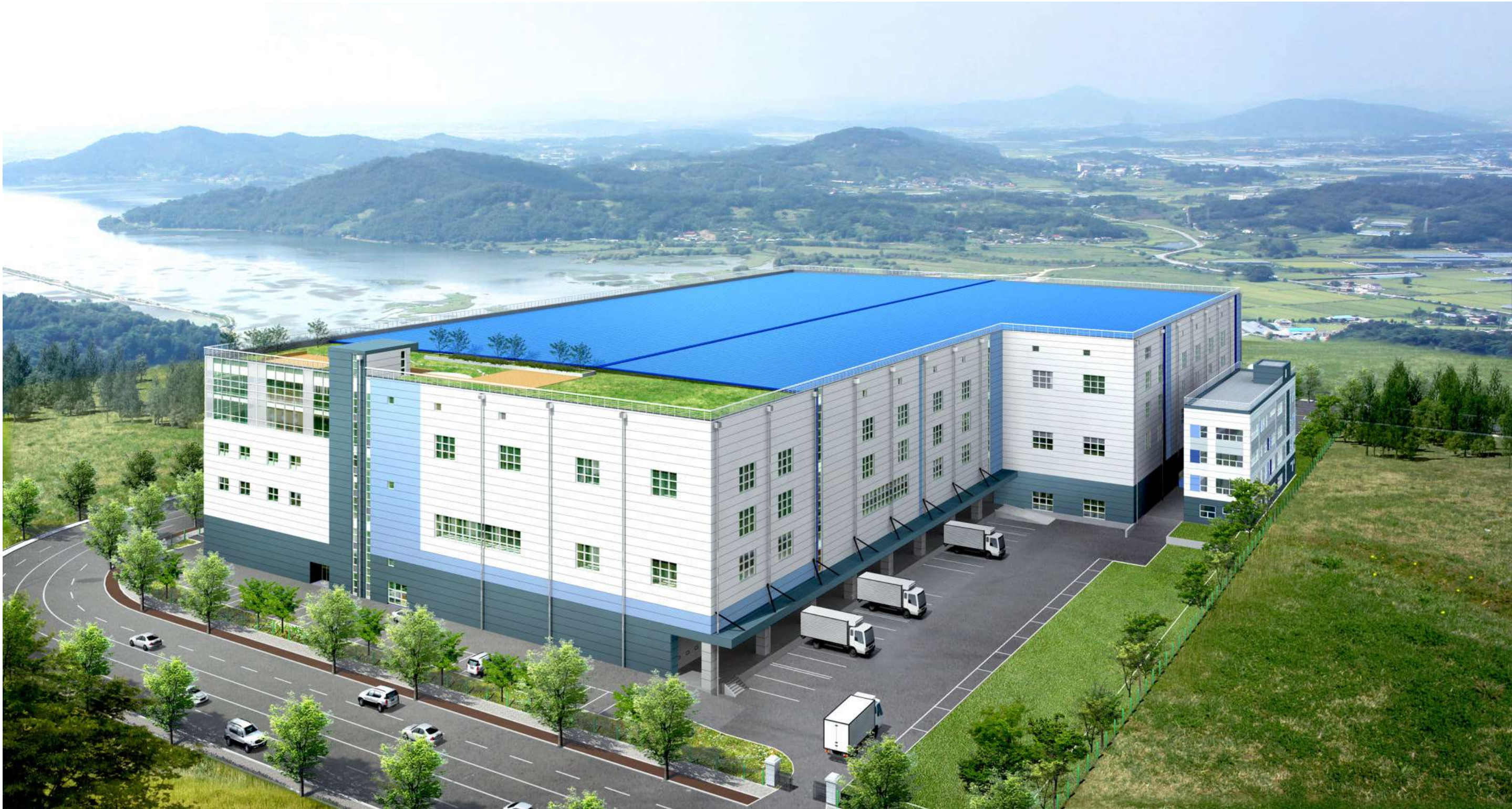
TJ Warehouse 인천 티제이 물류센터 신축공사
