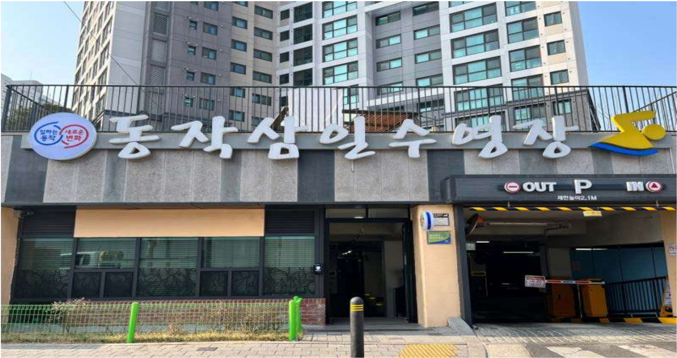
Sadang 1 Housing Reconstruction swimming pool 사당1주택재건축정비사업 체육시설(수영장) 신축공사
