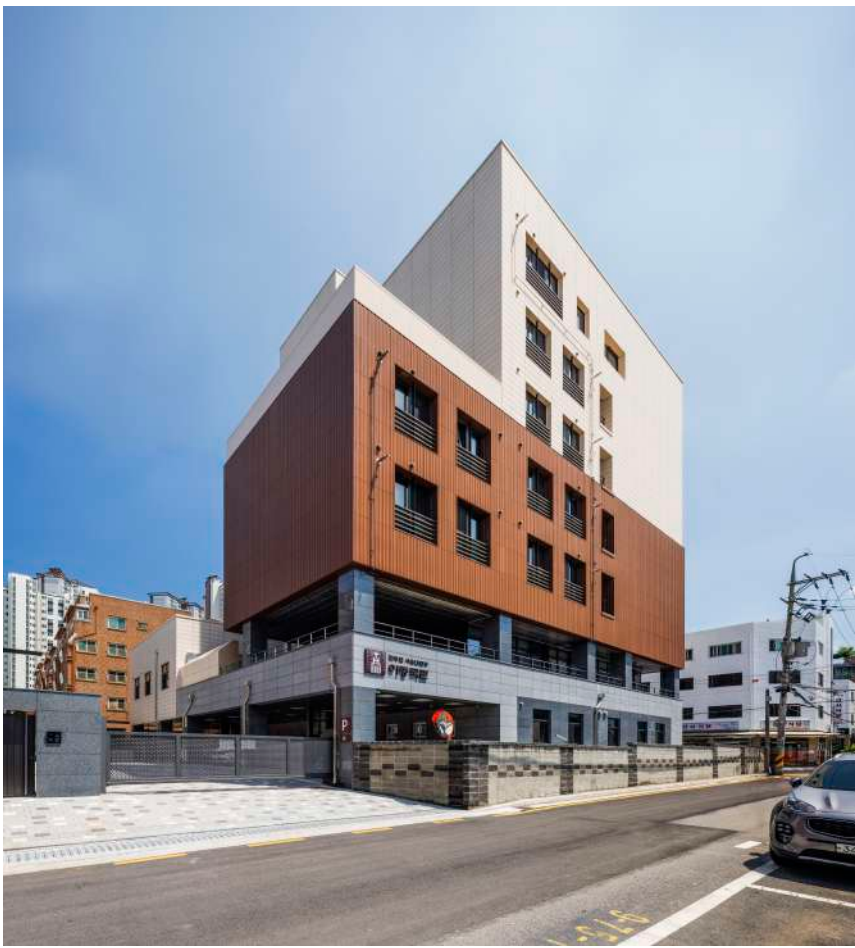
Amasa-dong Religious Facility 암사동 450-1 종교시설 신축공사
