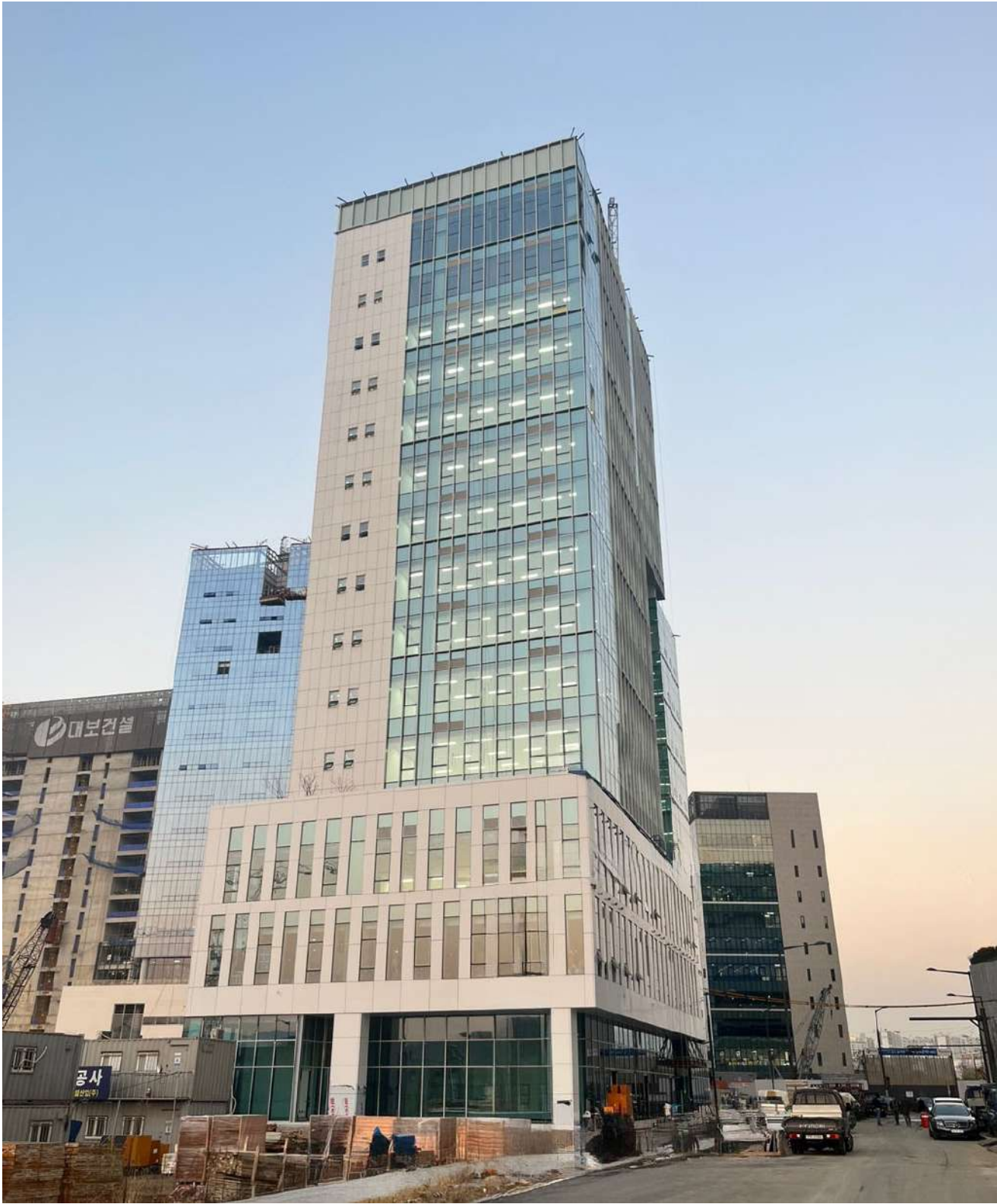
RFTech Headquater 강동 알에프텍 신사옥 신축공사
